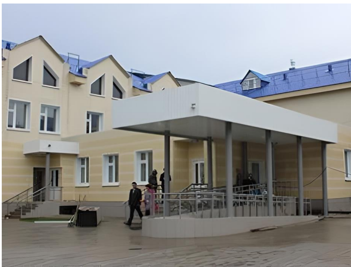
Рис 3. Корпус инфекционного отделения БУ «Мегионская городская больница»
